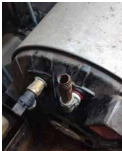
Figuur 2: Verwydering van die waterverwarmer se koperpype.
