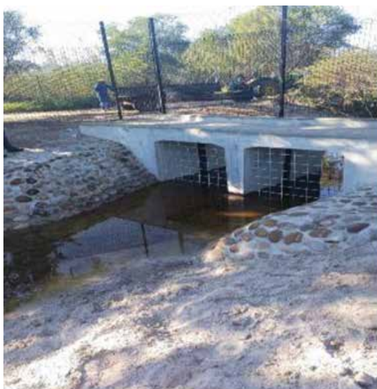
Installering van veiligheidsheining en remediërende werk aan die brug by die GD-fasiliteit
