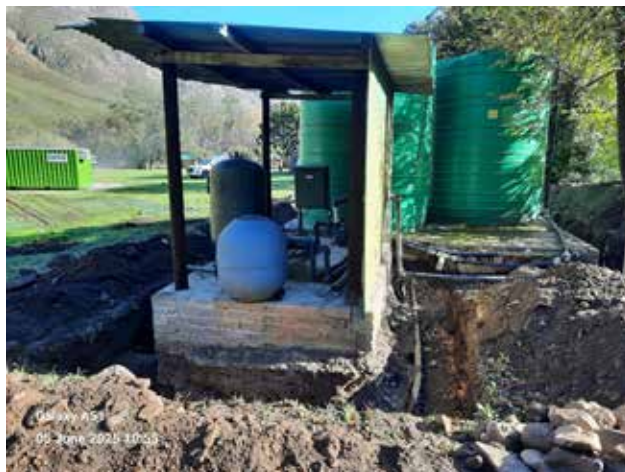
Opgradering van die boorgatstelsel en vervanging van verouderde waterbergingstenks.
