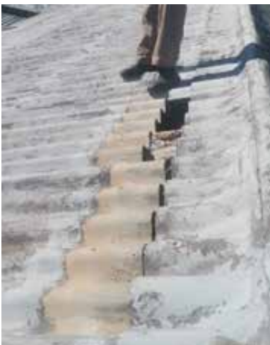
Figuur 1: Toegang is verkry deur dakteëls te verwyder.
