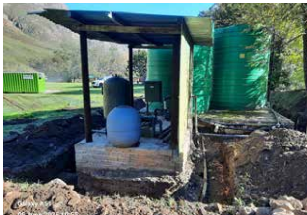
Ukuhlaziywa kwesixokelelwano sesitsala manzi nokufakelwa kwamatanki okugcina amanzi aphelileyo.
