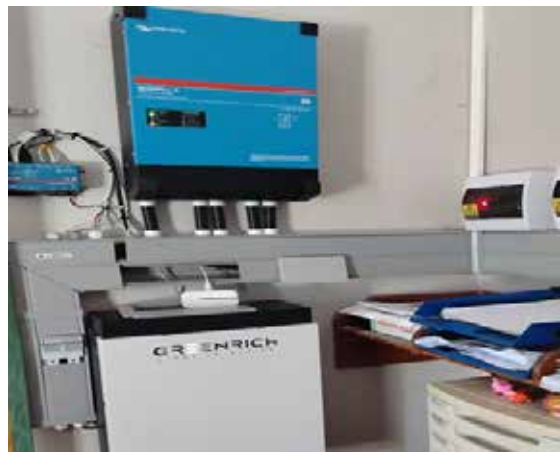
Inkqubo yeinvetha eya kwiCCTV kwiiko laseGD.
